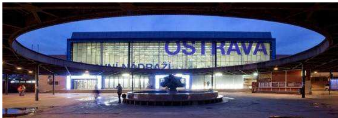
obrázek 6 - Výpravní budova Hl.n. Ostrava – 24.hodinová fasáda - noční pohled (Foto, archiv autora)
