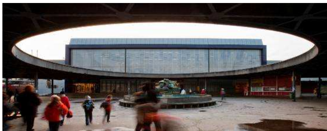
obrázek 5 – Výpravní budova Hl.n. Ostrava – 24.hodinová fasáda - denní pohled (Foto, archiv autora)
