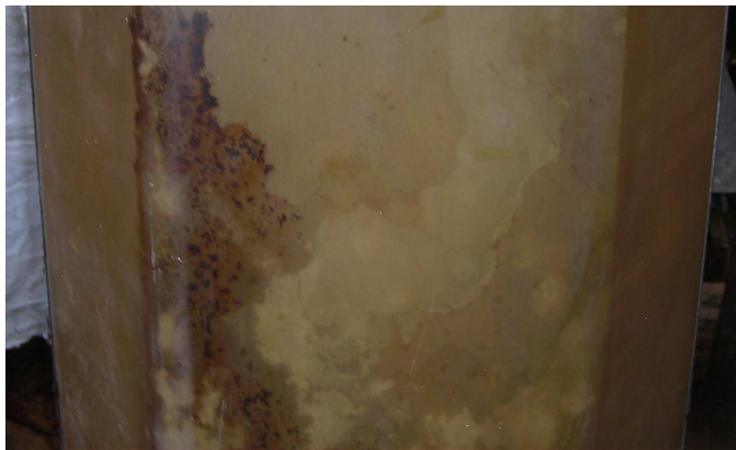
Obr.2 – Účinky kondenzace vodních par ve vnitřním prostoru svítidla
